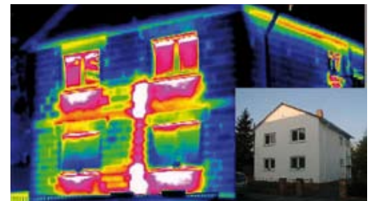
Aufnahme mit einer Wärmebildkamera
