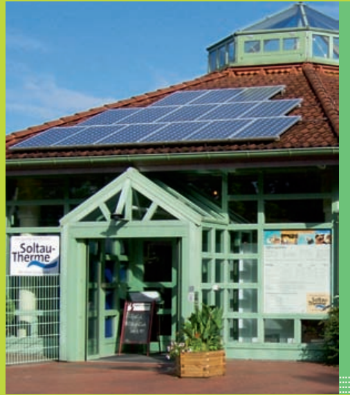
energreen -PV-Anlage auf dem Dach der Soltau-Therme
